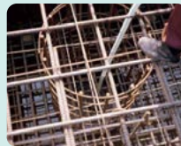
建築現場では鉄筋下の雨水溜り水の排水に活躍します。
